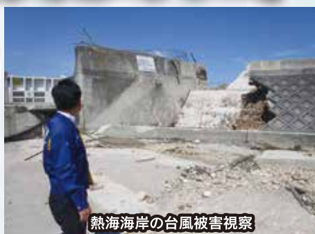
熱海海岸の台風被害視察
